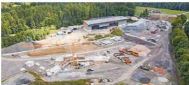
Celtor a terminé ses travaux liés à l'extension de la décharge et au déplacement de la route cantonale.
